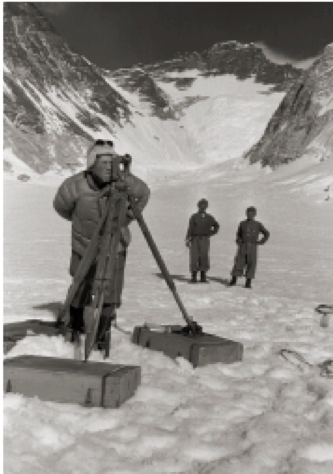
Müller fixiert mit dem Theodolit vom Western Cwm aus Messpunkte für seine Untersuchungen über die Fließgeschwindigkeit des Khumbugletschers.
